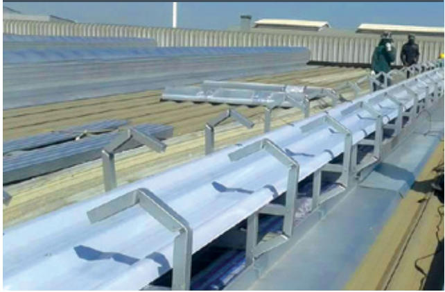
2. ติดตั้งฐานแผ่นครอบ และแผ่นโปร่งแสง
