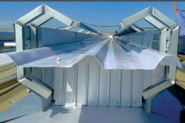
3. ติดตั้งแผ่นผนังเหล็ก
