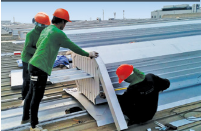
4. ติดตั้งแผ่นครอบ
