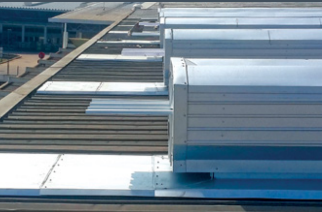
5. ติดตั้งแผ่นครอบข้างพิเศษ เพื่อป้องกันน้ำฝนย้อนเข้าอาคาร
