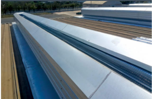
6. ติดตั้งตะแกรง Wiremesh เพื่อป้องกันนกเข้าอาคาร
