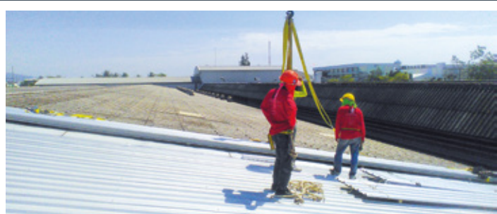
KS Reroof & Renovate / การปรับปรุงซ่อมแซมหลังคา
